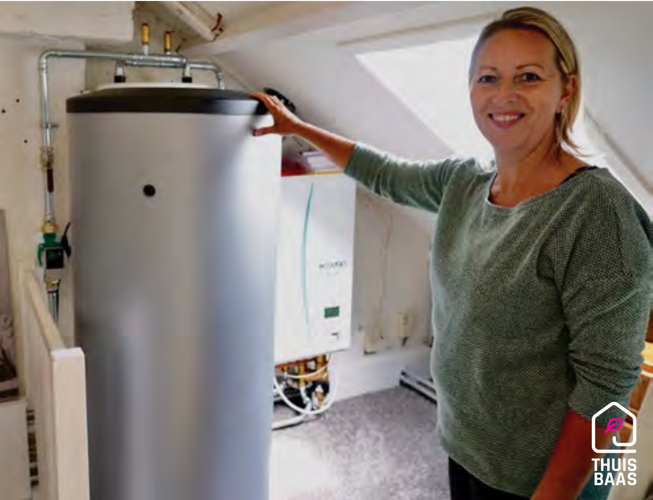
Binnen-unit lucht-water warmtepomp
