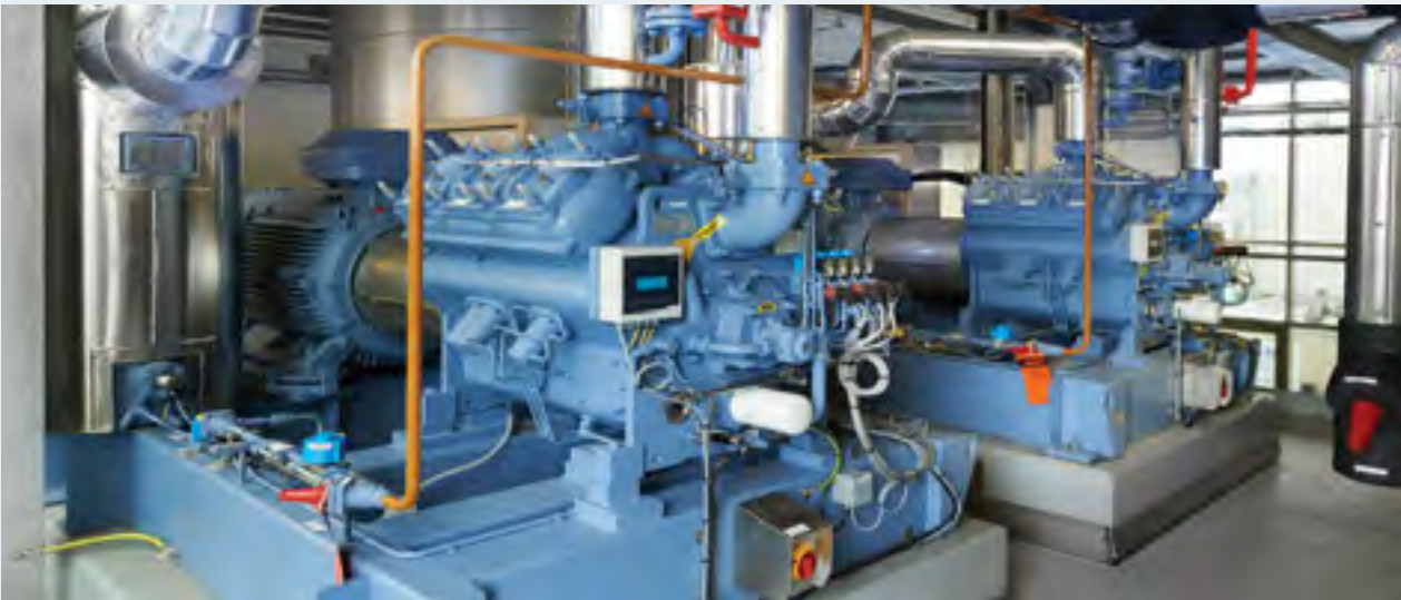
Met industriële warmtepompen kun je efficiënt restwarmte benutten en gebruik van aardgas voorkomen.
